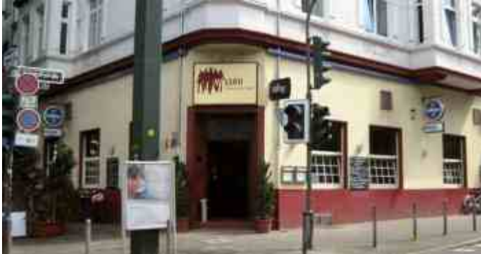
Das Vossen an der Hütte-/Helmholtzstraße
