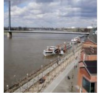
Blick in Richtung Oberkasseler Brücke
