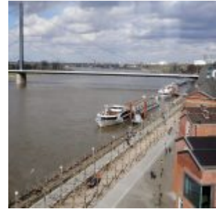
Blick in Richtung Oberkasseler Brücke
