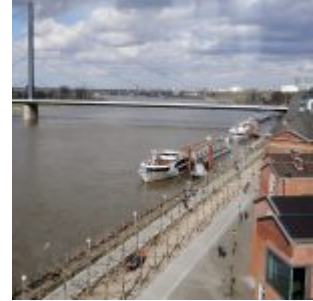
Blick in Richtung Oberkasseler Brücke
