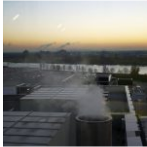
Blick nach Südwesten
