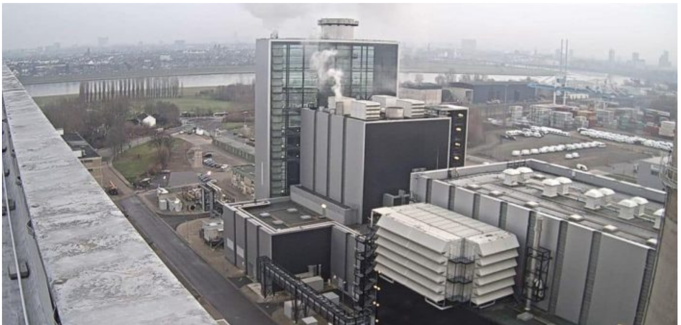
Blick auf den Block Fortuna des Kraftwerks auf der Lausward (Screenshot)
