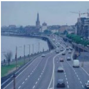
Die provisorische B1 während der Bauzeit
