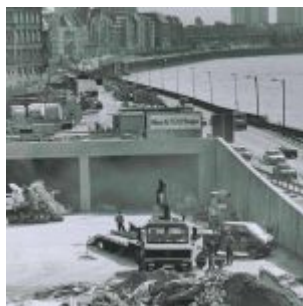
Zustand der Baustelle 100 Tage vor der Eröffnung
