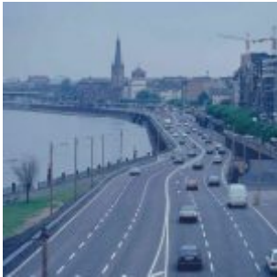
Die provisorische B1 während der Bauzeit
