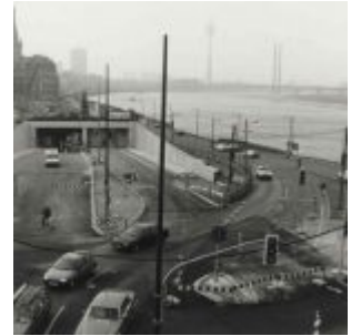
Tunnel im Bau um 1992
