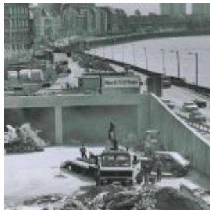
Zustand der Baustelle 100 Tage vor der Eröffnung
