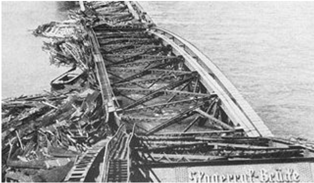
Die gesprengte Skagerrak-Brücke (Oberkasseler Brücke) 1945
