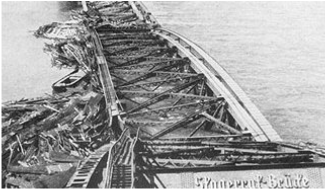
Die gesprengte Skagerrak-Brücke (Oberkasseler Brücke) 1945
