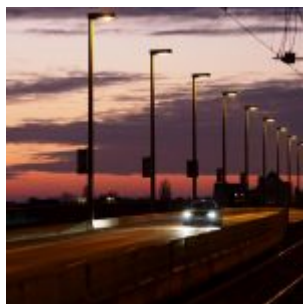
Platz 8: Oberkasseler Brücke (Hajo Kendelbacher)
