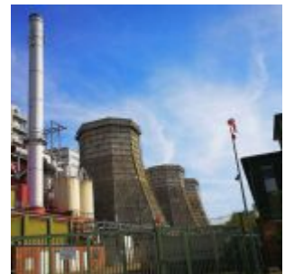
Kühltürme im Kraftwerk Flingern
