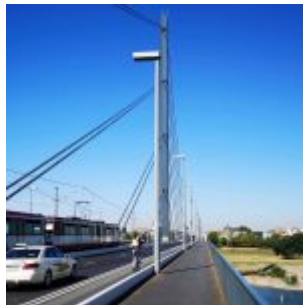
Auf der Oberkasseler Brücke
