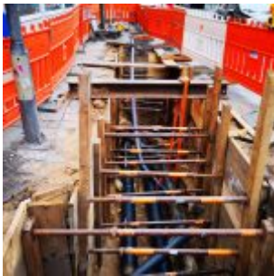
Baugrube, Oberbilker Allee
