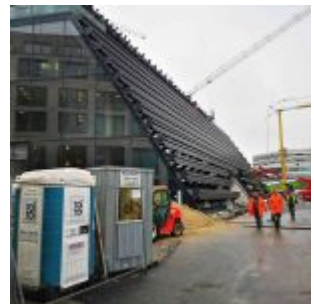
Ingenhoven-Tal im Bau
