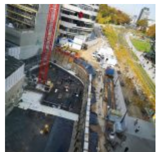
Baustelle am Kö-Bogen
