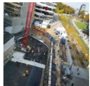
Baustelle am Kö-Bogen
