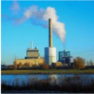
Kraftwerk Lausward in der Kälte
