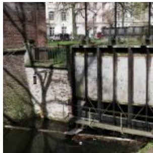
Sperrwerk am Spee'schen Graben
