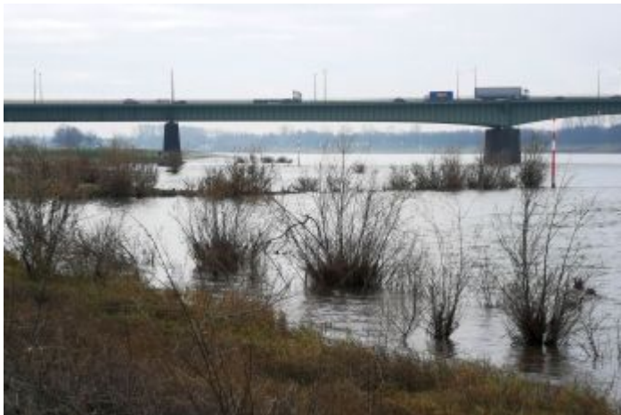
Hochwasser an der Südbrücke
