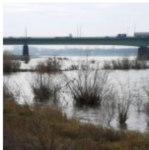
Hochwasser an der Südbrücke
