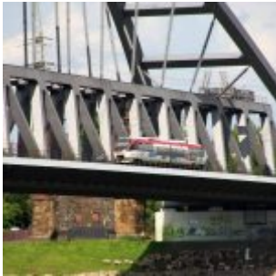
S28 auf der Hammer Eisenbahnbrücke (2009)
