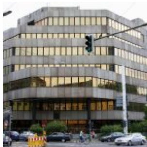
2009: Ein ehemaliges Gebäude der WestLB an der Elisabethstraße wird kernsaniert und umgenutzt (Foto: TD)
