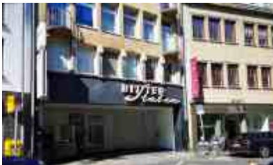
Ehemalige Ritter-Stuben, Wagnerstraße
