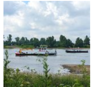
Arbeitsschiffe an der Panzerrampe
