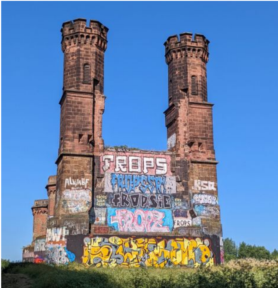
Brückenturm, Neusser Seite
