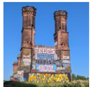
Brückenturm, Neusser Seite
