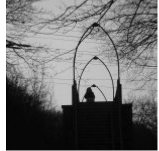
Fußgängerbrücke am Kleinfurst
