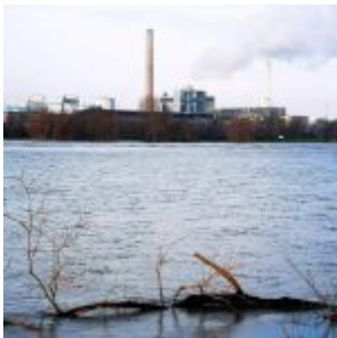
Blick zum Kraftwerk
