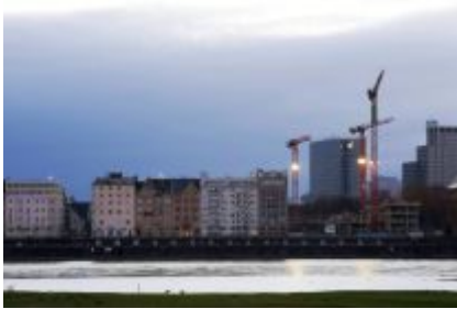
Baustelle an der Rheinuferpromenade
