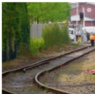
Gleisgänger, Kraftwerk Flingern
