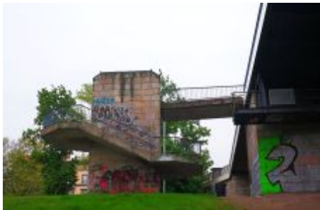
Aufgang an der Oberkasseler Brücke
