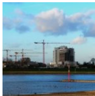
Baustelle Heerdter Krankenhaus
