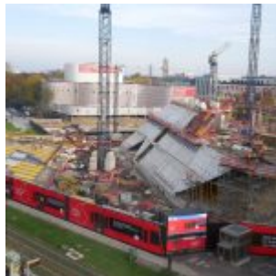
Baustelle Kö-Bogen II (2018)
