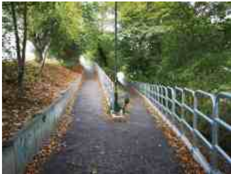
Fahrradrampe an der Südbrücke
