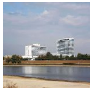
Hässlicher Neubau in Heerdt
