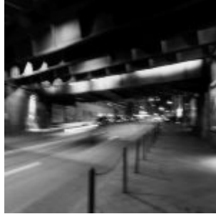
Unterführung Erkrather Straße
