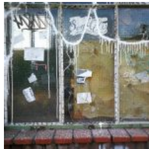
Fenster an der Vennhauser Straße
