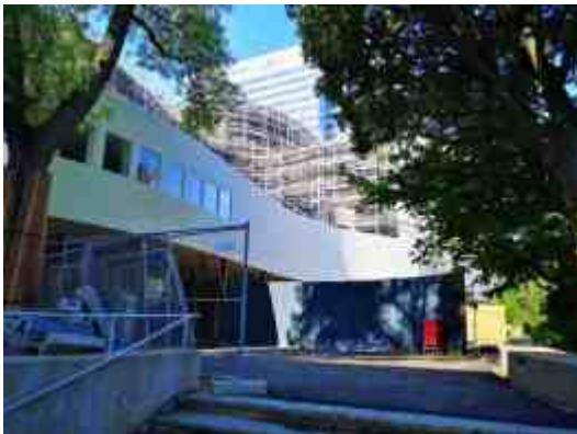
Schauspielhaus im Umbau
