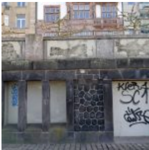
Noch sichtbar: Die Kasematten, die zum Hafen gehörten
