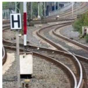
KW42: Gleise nördlich vom Hbf
