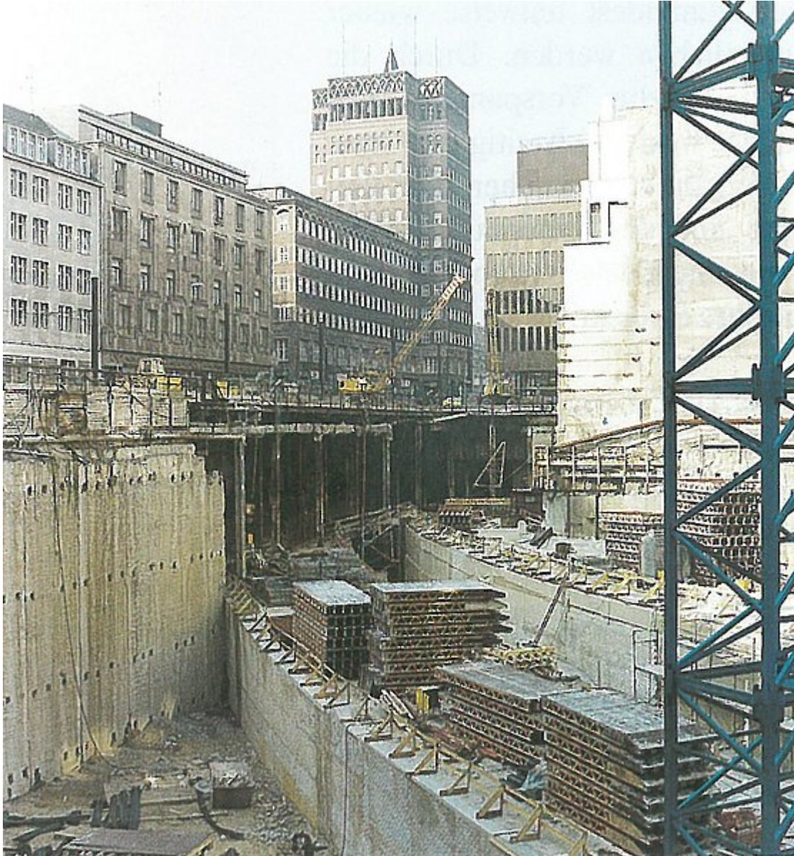
So wild ging es beim U-Bahn-Bau am Wilhelm-Marx-Haus zu (Foto: daub-ita.de)
