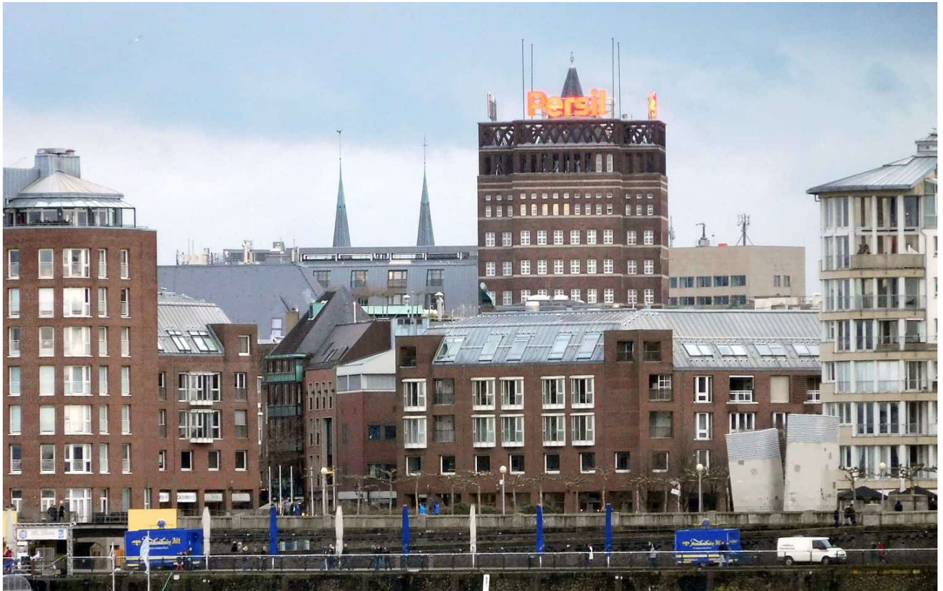
Damit fing die Ära der Hochhäuser in Düsseldorf an: das Wilhelm-Marx-Haus (Foto: TD)
