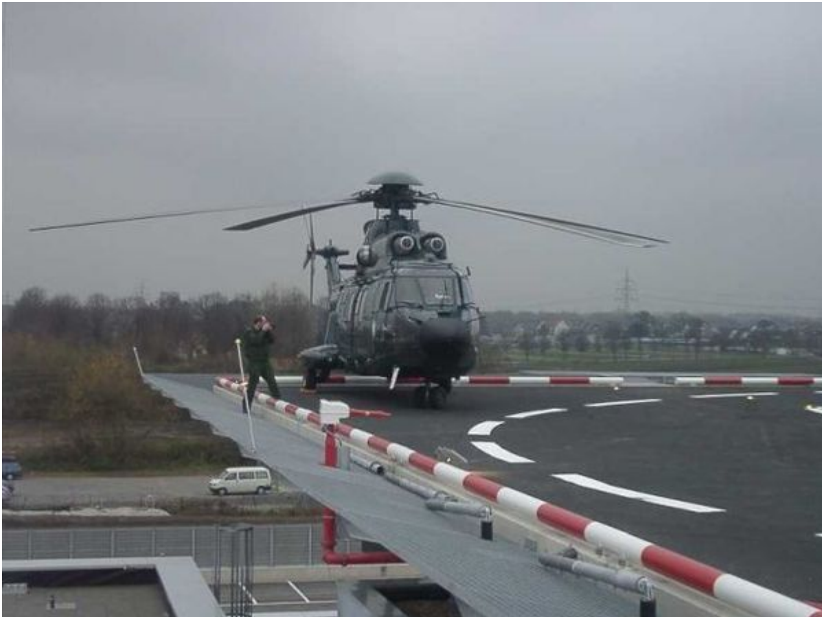
Das Helikopterdeck auf dem OLG-Prozessgebäude (Foto: OLG Düsseldorf)
