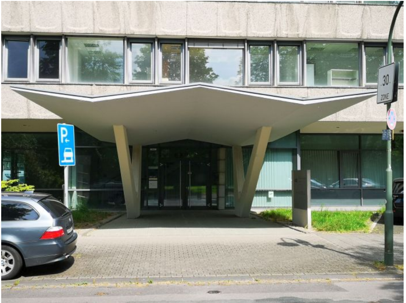
Das dynamisch gezackte Vordach (Foto: TD)
