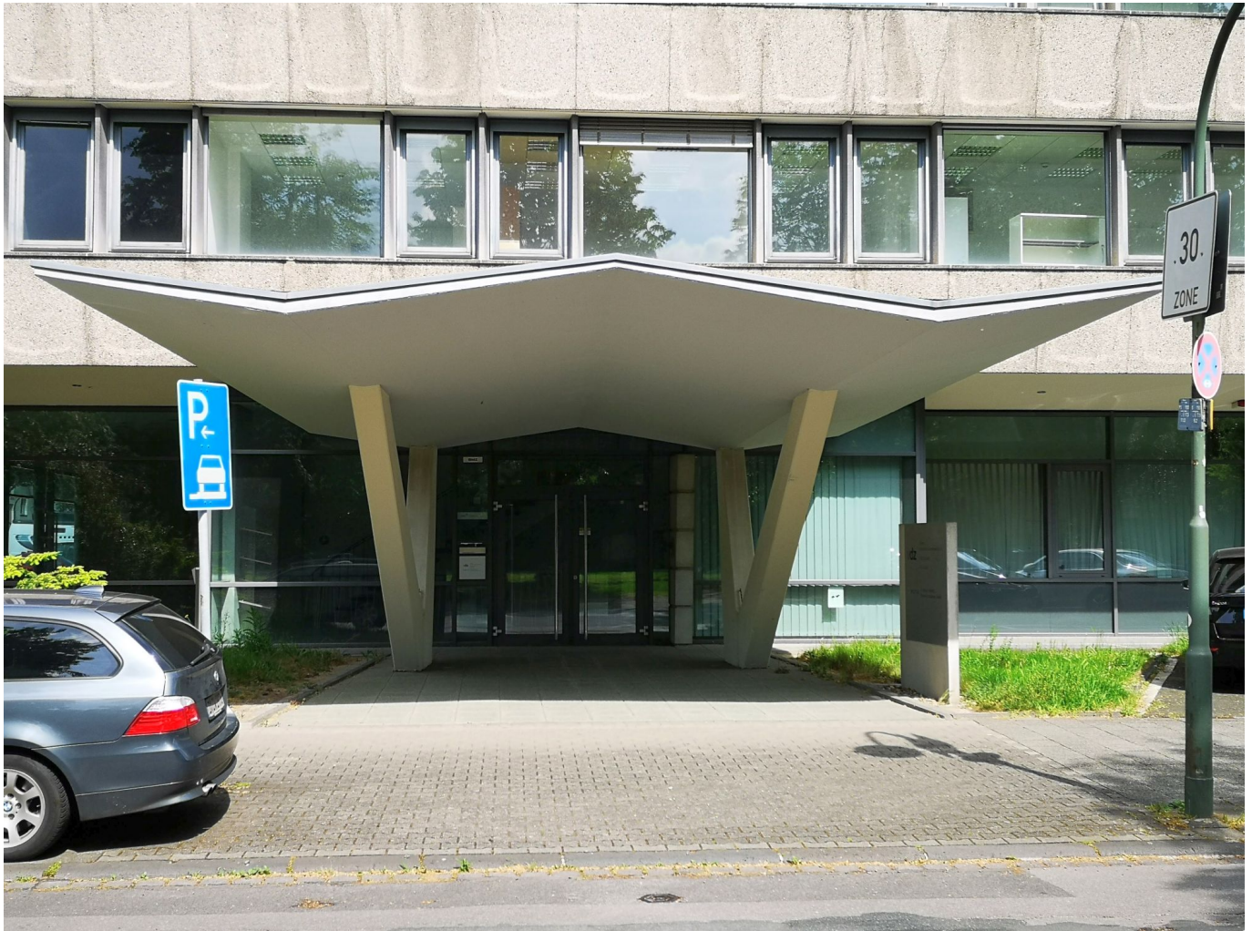
Das dynamisch gezackte Vordach (Foto: TD)
