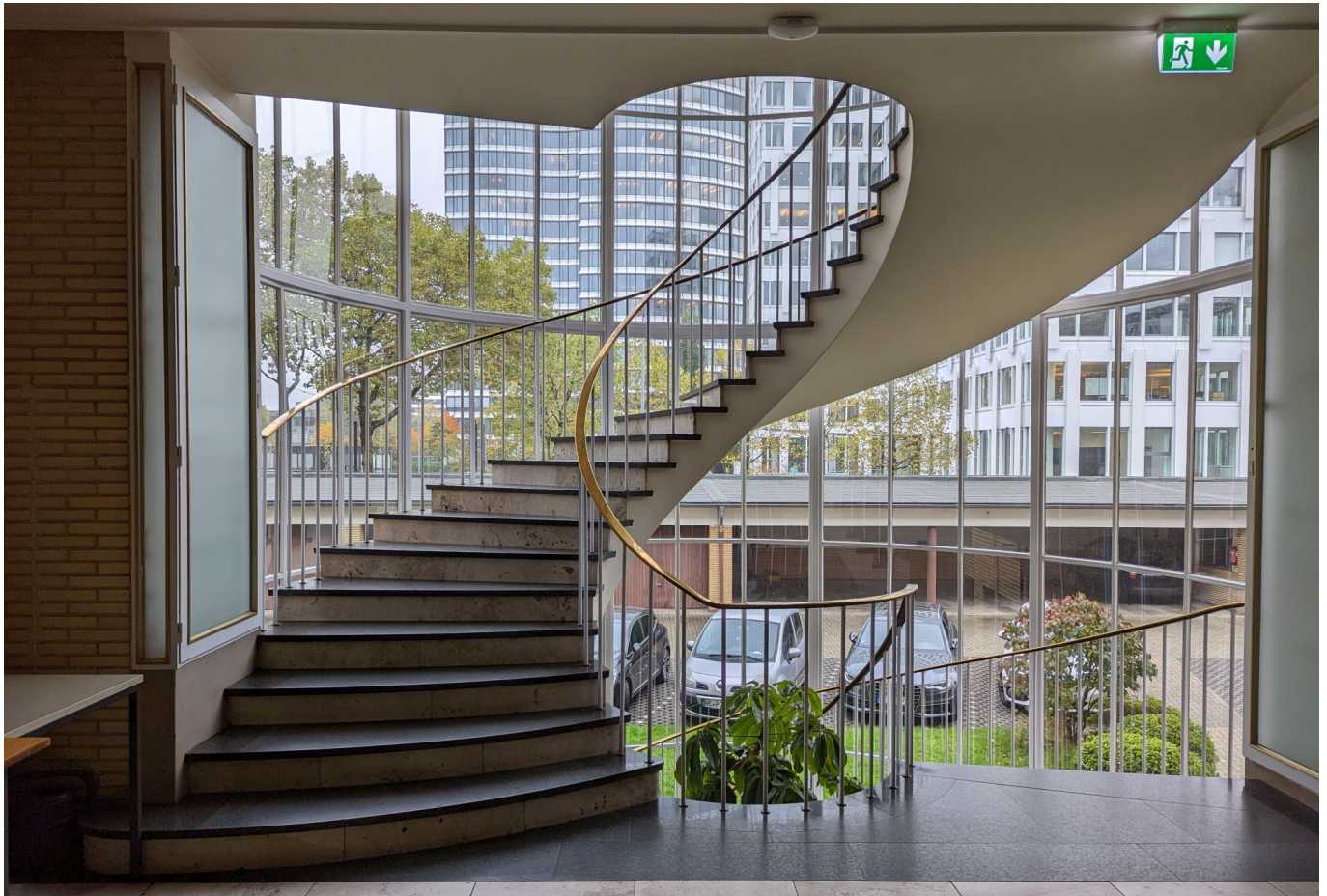
Die fein geschwungene Treppe im Drahthaus (Foto>: TD)
