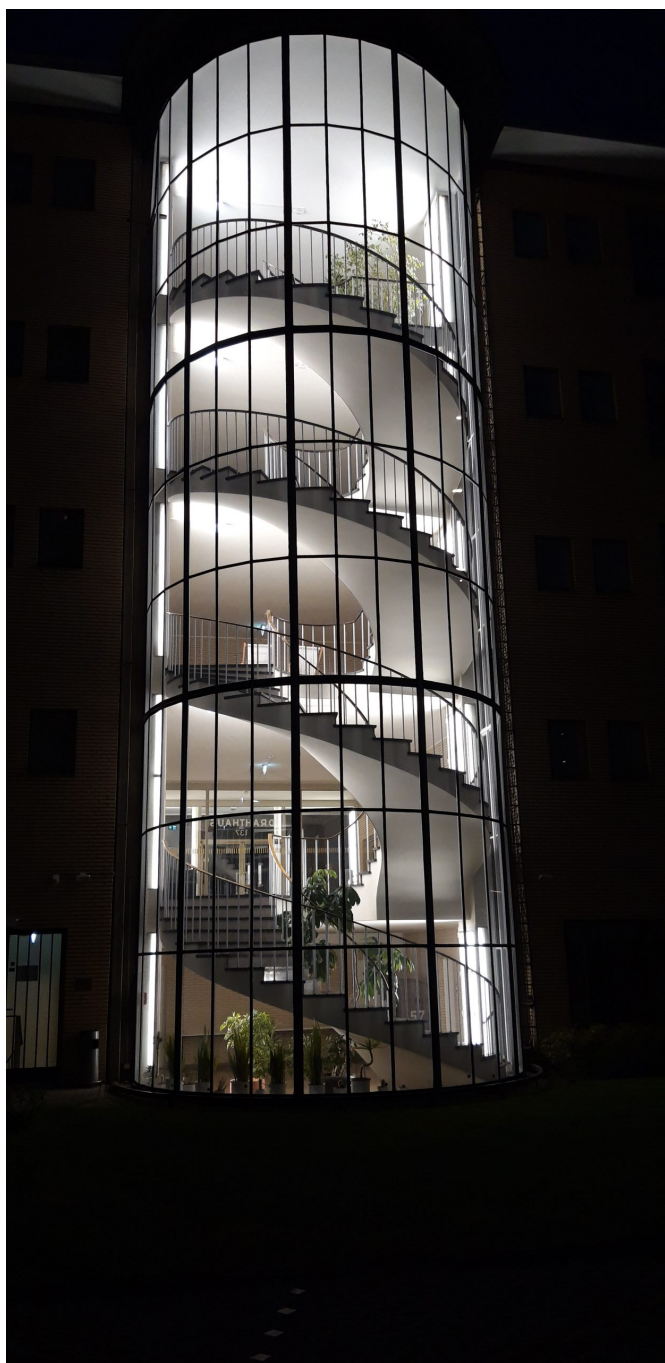
Das wunderschöne Treppenhaus von außen bei Nacht (Foto: Ingrid Sassen)
