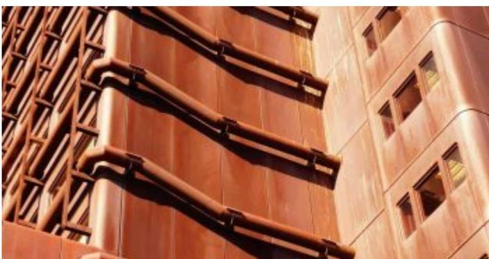
Das Heim der NRW-Statistiker ist eines der ersten und eines der größten Gebäude überhaupt, dessen Fassade in **Corten-Stahl** ausgeführt wurde. Dieser Werkstoff bildet fast unmittelbar nach der Herstellung eine sichtbare Rostschicht aus; darunter aber entsteht an der Umgebungsluft eine sulfat- und
