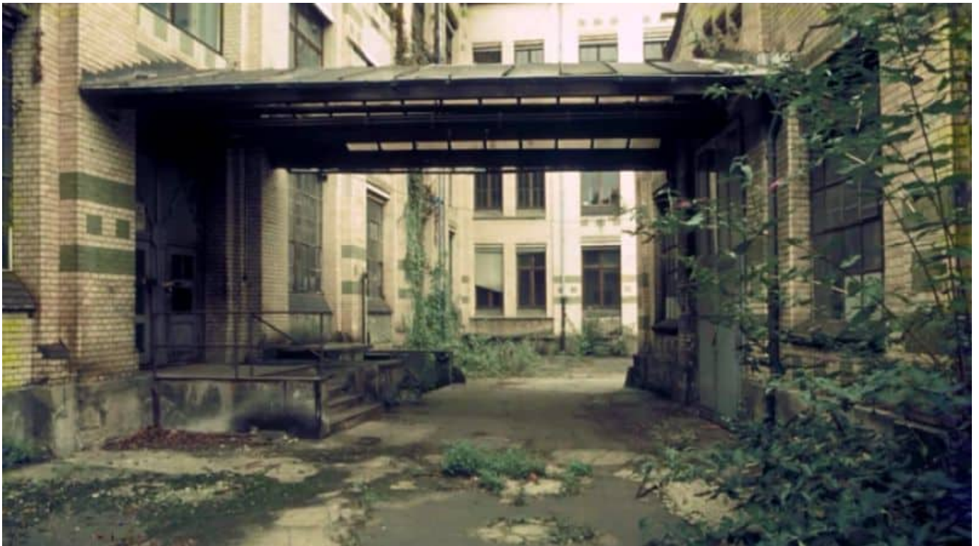
So sah es in der Jagenberg-Fabrik nach dem Aus in den 80ern aus (Foto: salzmannbau.de)
