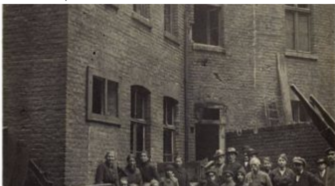
Die Schäden am Oberbilker Markt durch das Freikorps Lichtschlag
