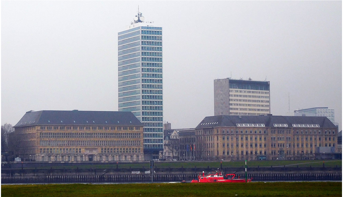
Mannesmann-Hochhaus und Peter-Behrens-Bau (Foto: TD)
