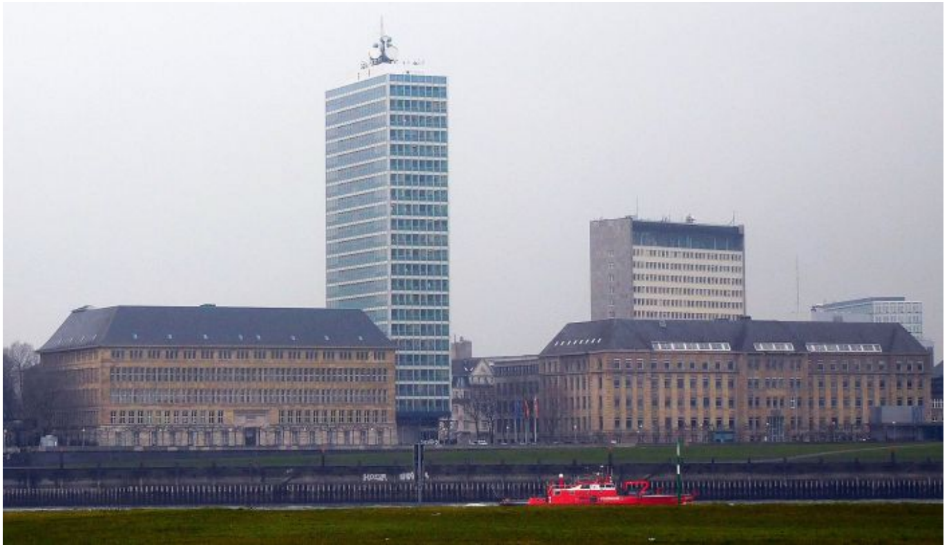
Mannesmann-Hochhaus und Peter-Behrens-Bau (Foto: TD)
