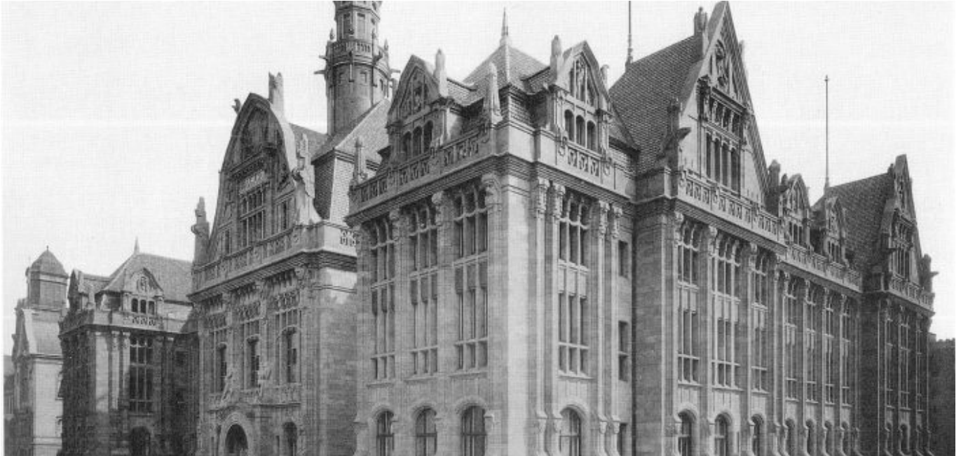
Der Stahlhof noch vor seiner Eröffnung im Jahr 1909 gesehen von der Ecke Kasernen-/Bastionstraße (public domain via Wikimedia)
