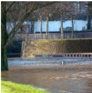
10.1.2011: Wassermassen unter der Kniebrücke
