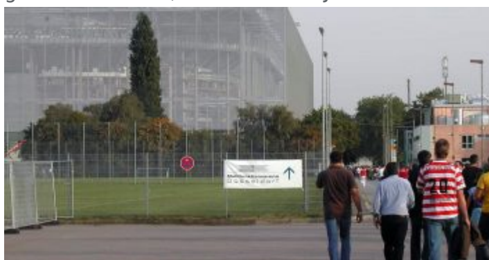
10.9.2004: Joachim Erwins Multifunktionsarena beim Soft-Opening
