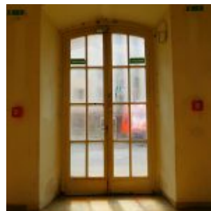
Notausgang am Treppenhaus
