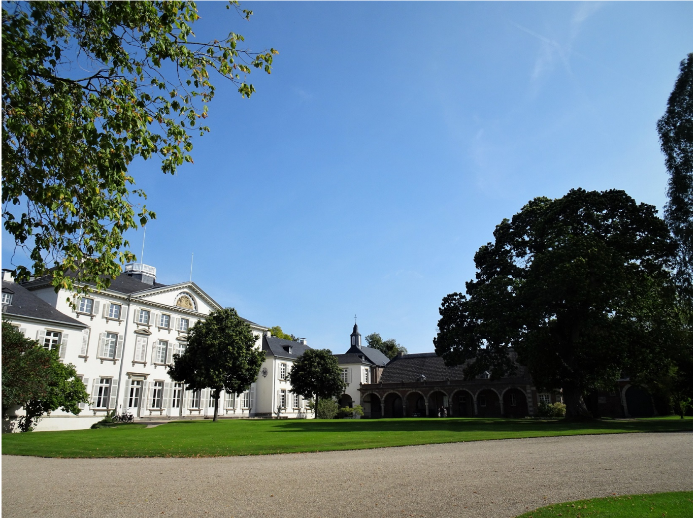
Blick über den Innenhof aufs Herrenhaus (Foto Gisela Wiemer für TD)
