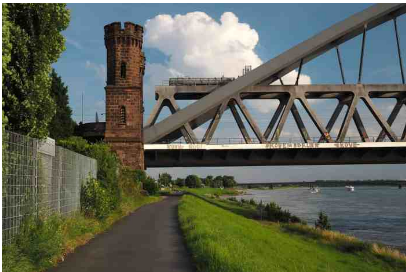
Die Hammer Eisenbahnbrücke vom Rheindeich aus gesehen (Foto: TD)
