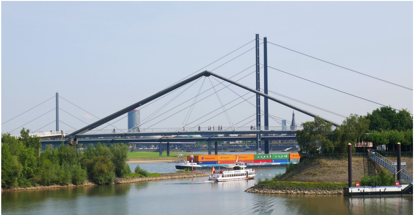
Fußgängerbrücke über die Hafeneinfahrt (Foto: TD)
